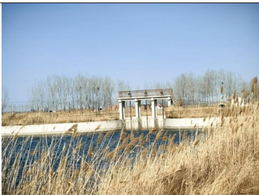
现状穿堤建筑物
