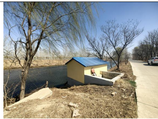
现状穿堤建筑物
