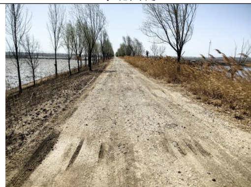
I区分区滞洪围堤堤顶路
